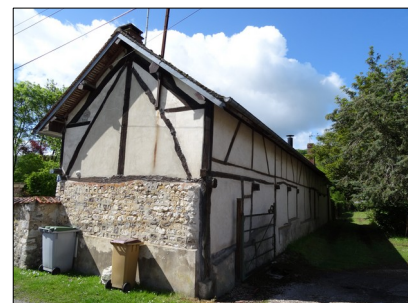
Exemple d'une charpente de chaumière retravaillée avec sa ferme d'origine
