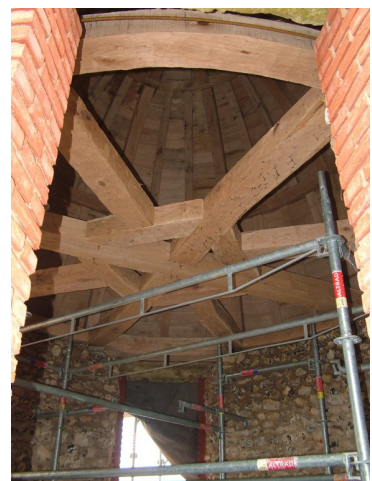
maisons paysannes de l'eure – reportage sur la restitution d'une charpente façon médiévale Le savoir-faire ancien du charpentier Rémy Desmots
