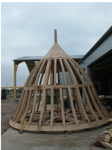
maisons paysannes de l'eure – reportage sur la restitution d'une charpente façon médiévale Le savoir-faire ancien du charpentier Rémy Desmots
