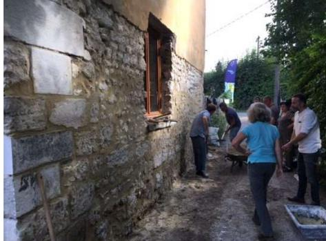
**Gobetis** : 2 vol de sables pour 1 vol de chaux, **Corps d'enduit** : 2,5 vol de chaux pour 1 vol de chaux, **Finition** : 3 vol de sable pour 1 vol de chaux NHL2 pour la terre, NHL 3,5 pour la pierre, NHL 5 pour les soubassements
