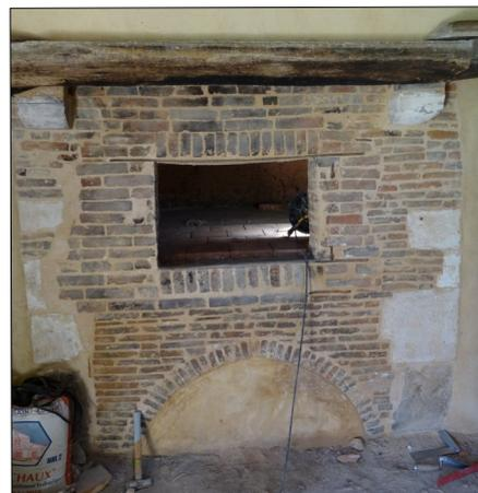
Réfection de la sole (ou âtre): Pose de carreaux de terre cuite à plat(22 x 22 ép.5 cm) sur lit de sable et terre, sans aucun scellement de mortier. La cendre finie occupera les interstices de dilatation.
