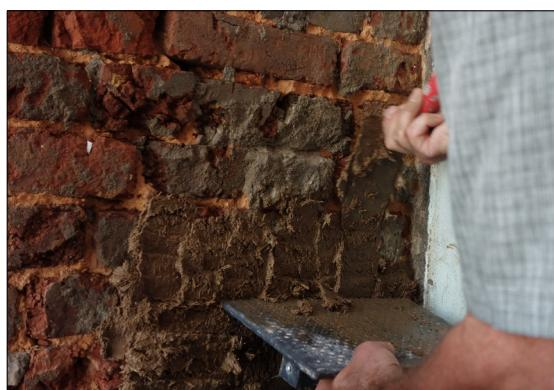
L'enduit de la première couche est composé de terre, de sable/sablon et d'anas de lin. Au mortier de finition, l'ajout de chaux NHL2 a permis d'éclaircir le mélange.
