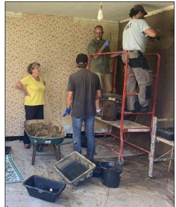
La journée s'est déroulée en trois étapes : pose d'une première couche à la fois renforçante et corps d'enduit, pour uniformiser les niveaux, ajout d'une couche de finition (après le prise de la première) puis serrage/lissage. Cette dernière étape est la plus délicate, d'elle dépend l'aspect fini (planéité, fissurage, etc.). Elle peut être complétée par un travail à l'éponge.
